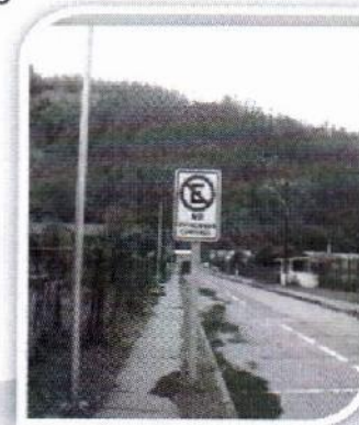
Instalación de RPO-13 No Estacionamiento Camiones
