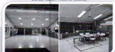
Normalización Sistema Eléctrico
