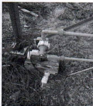
INSTALACIÓN BOMBA DE AGUA ESCUELA GRANO DE TRIGO.
