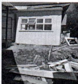
REPARACIÓN COCINA ESCUELA NAHUELBUTA
