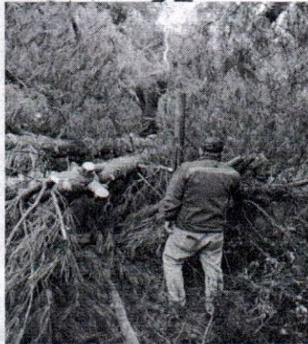
DESPEJE Y LIMPIEZA POR CAIDA DE ARBOL. ESC. HUALLEPEN ALTO
