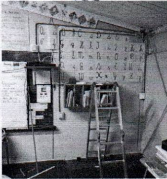
MEJORAMIENTO ELECTRICO ESC. HUIDE
