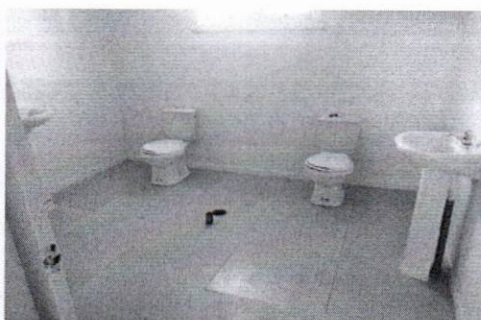
REPARACIÓN DE BAÑOS GIMNASIO ESCUELA CALEBU. - CAMBIO DE LLAVES LAVAMANO - PINTURA INTERIOR
